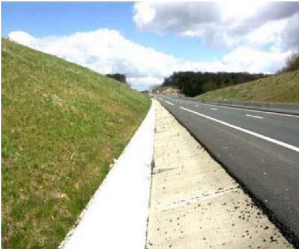
: Réseaux d'assainissement d'un pied de talus de déblai
